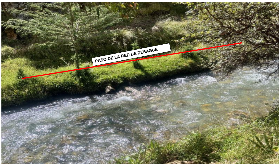
FIGURA N°02: SE OBSERVA LA MARGEN DERECHA DEL RIO LA CUAL ES VULNERABLE ANTE UNA CREDIDA, POR DICHO LADO PARA LA RED DE DESAGUE.
